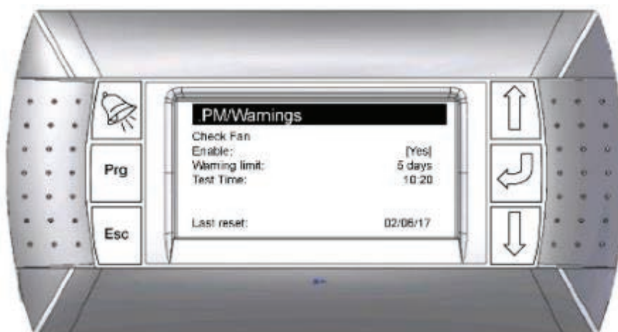
Lüfter prüfen: Bildschirm 1 von 2
